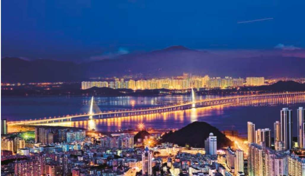
Shenzhen Bay Bridge @SZAICE
