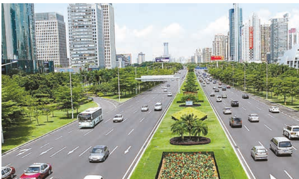
Shennan Road @SZAICE
